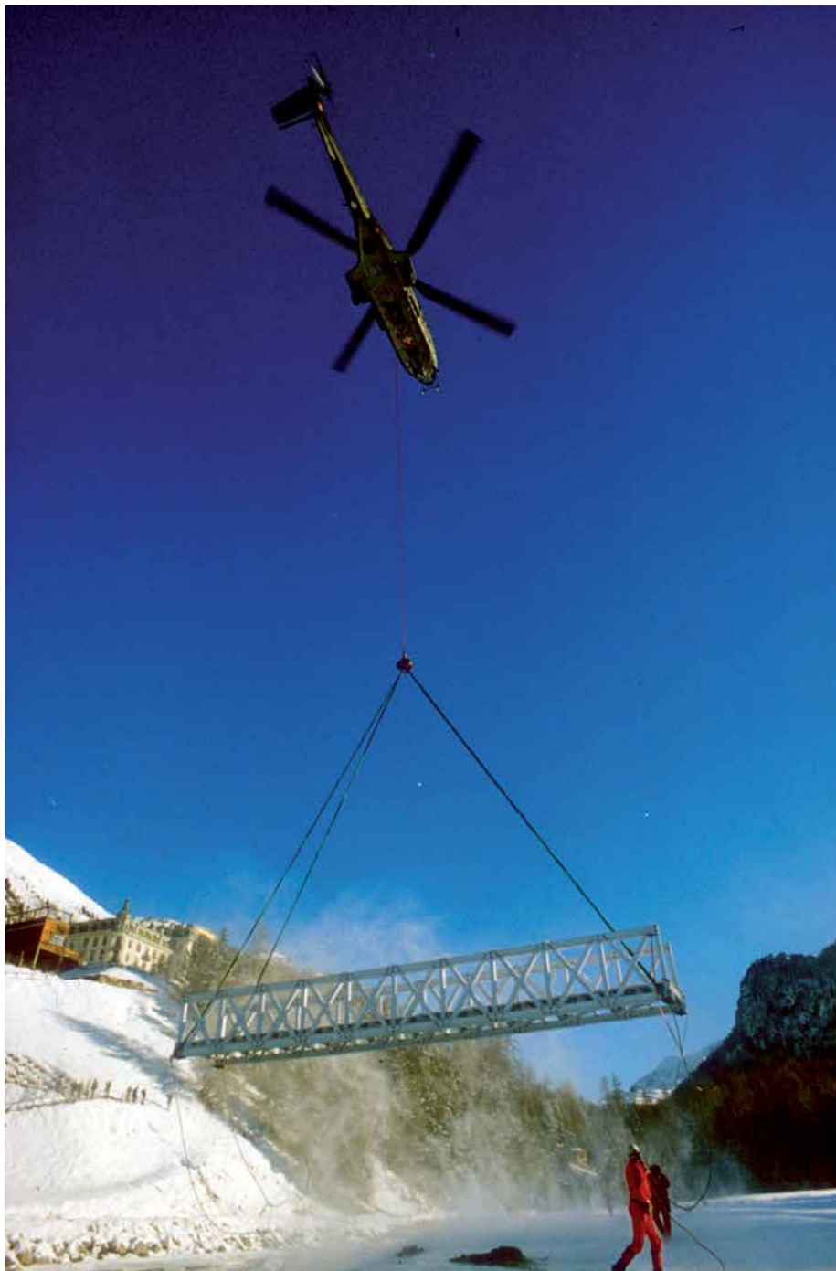
Die Pultrusionsprofil-Brücke bei Pontresina wird jeweils für die Wintersport-Saison installiert.
